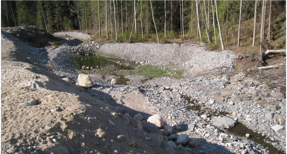
Kuva 23. Hulevesien purkupisteeseen Vanhatalossa rakennettiin hulevesiallas ja eroosiosuojausta Hirvikalliontien rakentamisen yhteydessä vuonna 2011. Kuvassa keskeneräisen hulevesialtaan rakennustyöt käynnissä [Ramboll 2011]
